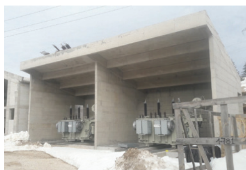
Izgradnja TS Zabljak
