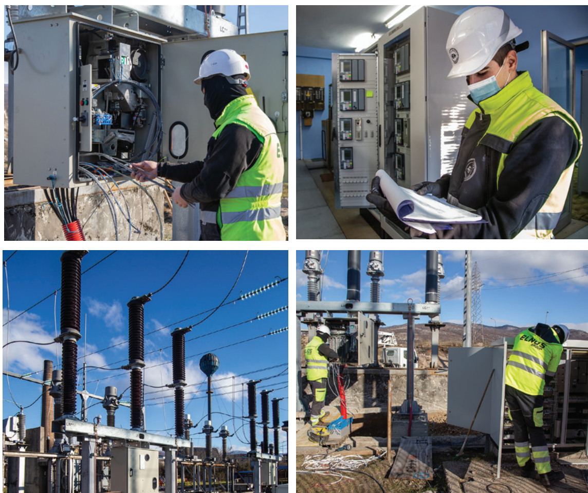
Zamjena VN opreme
